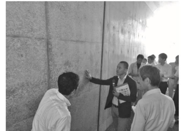
写真-2 山口市由良 IC ボックスカルバート内部 (2016年8月 著者撮影)
