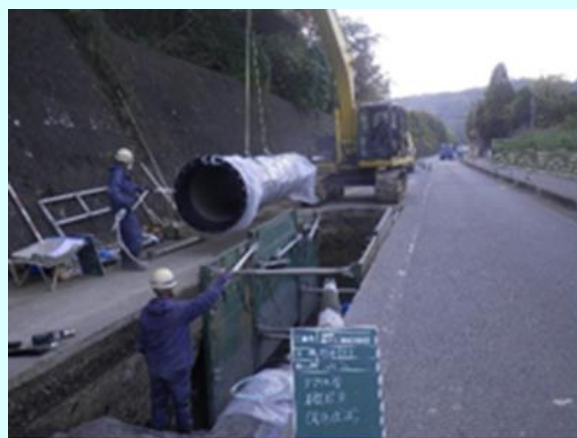
(写真:厚東川第2期工業用水道強靱化事業)
