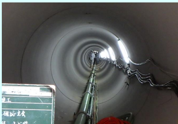
(写真:木屋川・木屋川第2期工業用水道二条化事業)
