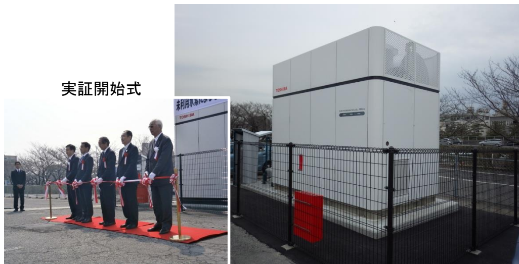
100kw純水素燃料電池の設置、苛性ソーダ工場からの供給配管による未利用副生水素の直接供給開始（H29年3月）
