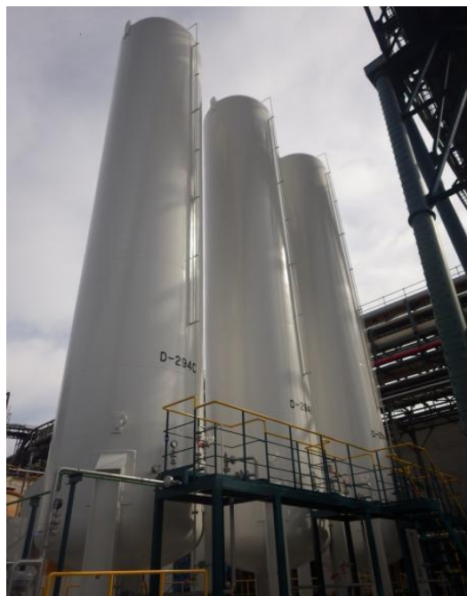
未利用水素回収用のバッファドラム設置（H28年10月）
