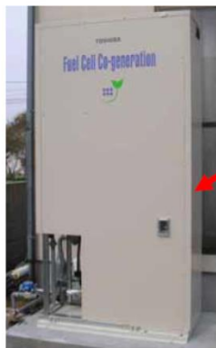
一般家庭に設置された水素供給燃料電池 (貯湯タンクー体型)
