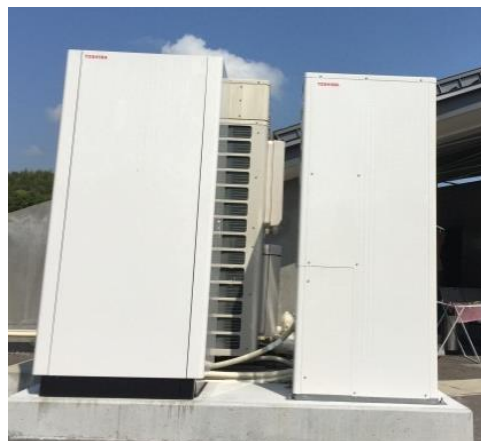
カードルで輸送した圧縮水素ガスの供給による 3.5kw純水素燃料電池の実証開始（H28年3月）
