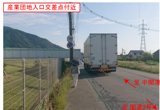
現道の課題（歩道未整備）
