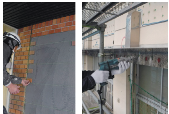
外壁改修工事
