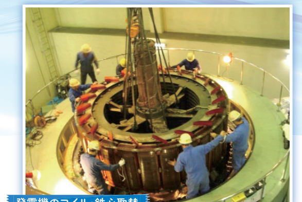
発電機のコイル・鉄心取替
