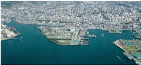
徳山下松港徳山地区海岸は、平成11年9月に来襲した18号台風により、背後地区に甚大な越波・浸水被害を受けたことから、高潮災害に対し、粘り強い海岸保全施設を構築すべく、護岸と胸壁の天端の高上げを行うことにより、背後地区を越波・浸水被害から防護します。
