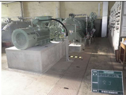
排水ポンプの整備
