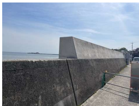
海岸保全のための護岸補強
