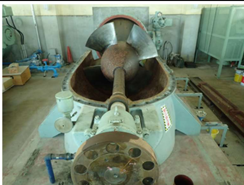
排水ポンプの分解整備
