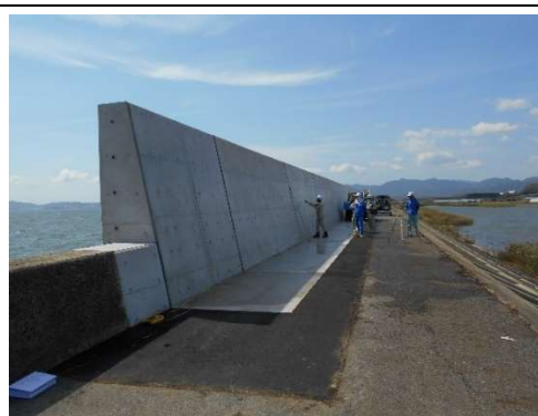
堤防の補強工事
