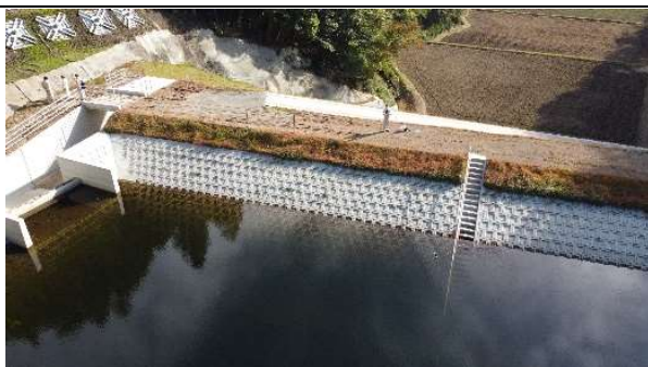
ため池の改修
