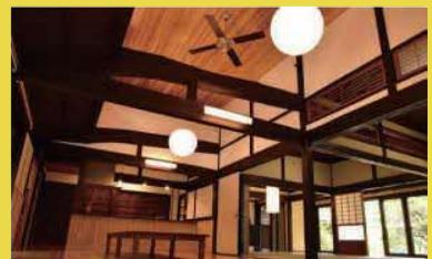
和室を LDK に改修、古い天井を取り除き隠れていた大きな梁をみせるようにした。高い位置に窓を設け、以前は暗かった北側の部屋に適度な明るさを確保した。
