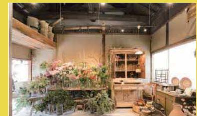
室内は土間にして靴で上がる様にした。もともとの土壁と梁を見るようにし、土壁は崩れないよう処理した。
