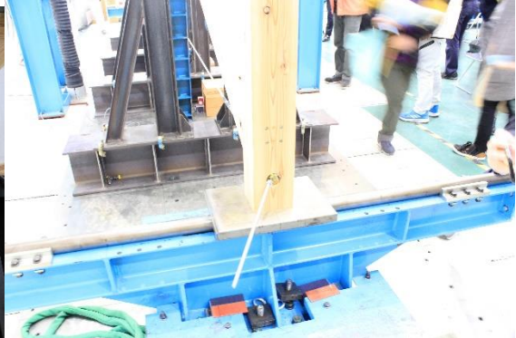
めり込み箇所
