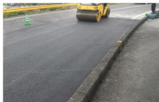
NTK再生アスファルト混合物RP20 施工状況
