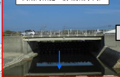
高潮対策施工前(防潮水門)
