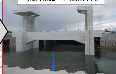
高潮対策施工中(防潮水門)
