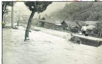
昭和29年9月洞爺丸台風 浸水状況
