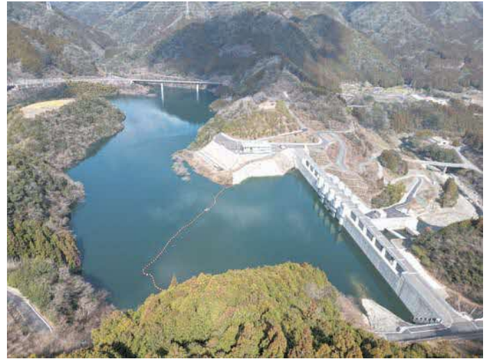
●試験湛水中の状況
