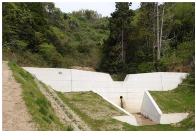
治山ダムの整備
