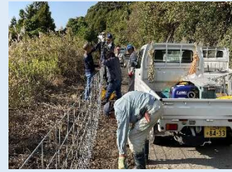
町道沿い設置状況
