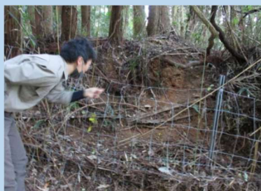
既設侵入防止柵の点検
