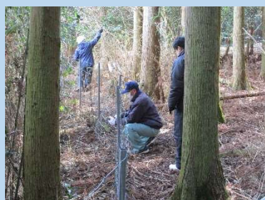
侵入防止柵の補修
