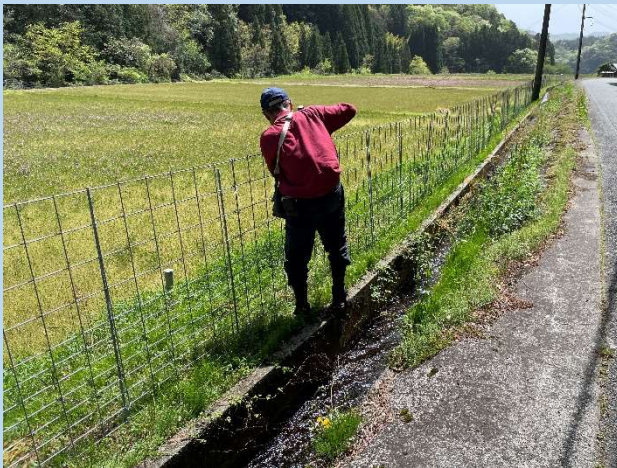
【イノシシ侵入防止柵の設置作業】
