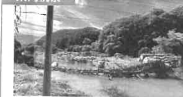
厚狭川(JR美祿線)被害状況を視察。
