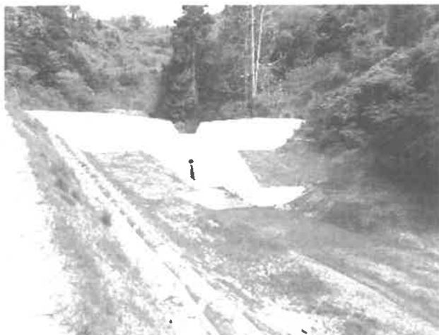
R2 山地災害箇所の復旧状況（谷止工）
