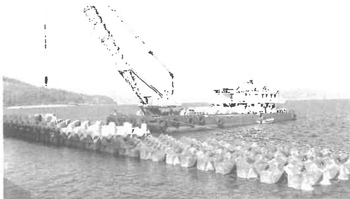
離岸堤工事（内入）
