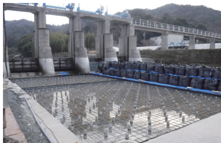
頭首工の修繕(防府市:防府総合堰)
