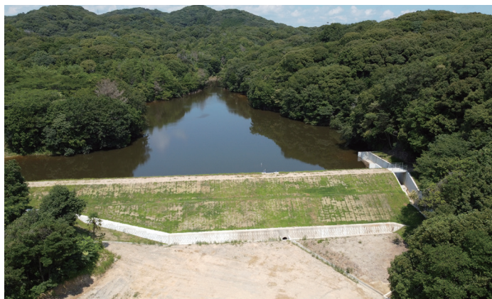
ため池の改修(宇部市:小野下)
