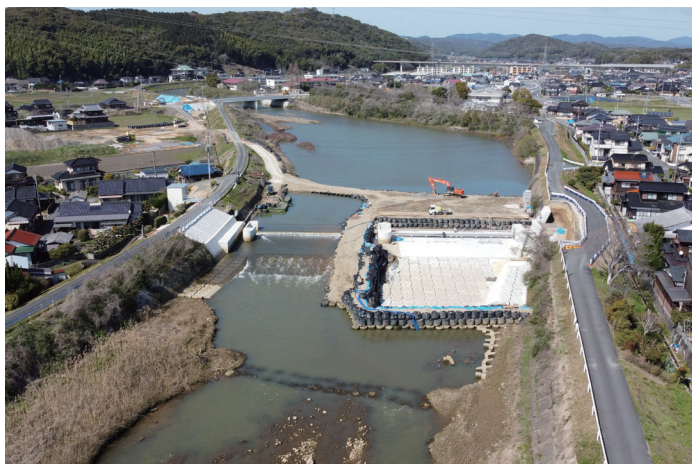
頭首工の改修(山陽小野田市:石井手)
