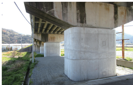
橋の耐震補強(長門市:長門大津)
