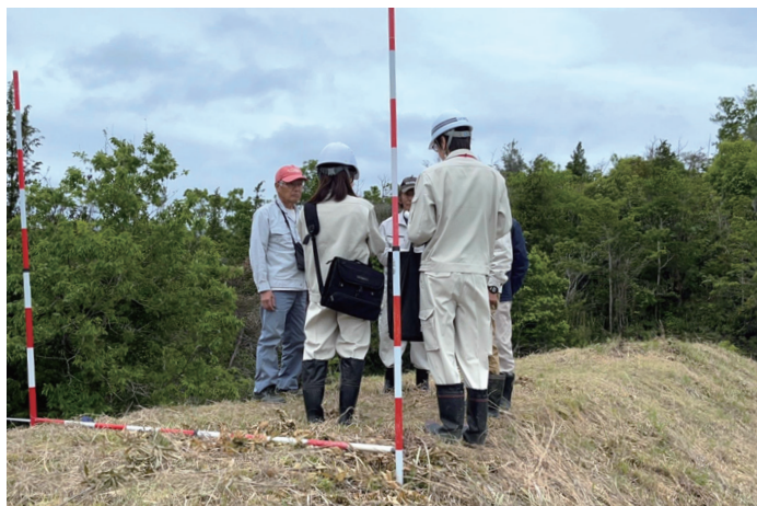
ため池点検パトロール
