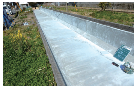
水路の補修(宇部市:御撫育)
