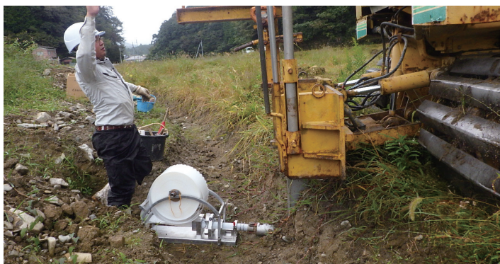
シートパイプ施工状況(周南市:長穂)
