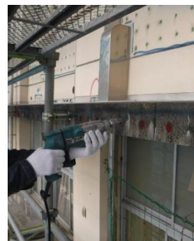
外壁改修工事
