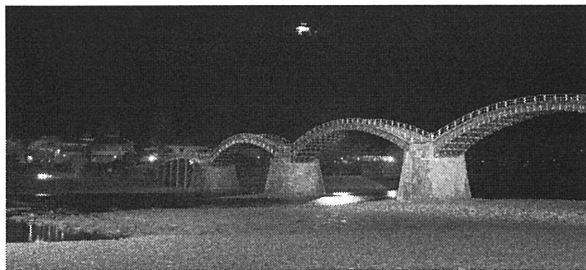
岩国市「錦帯橋」
