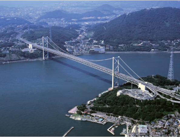
■関門橋の通行止め状況 (R1～R5年度)
