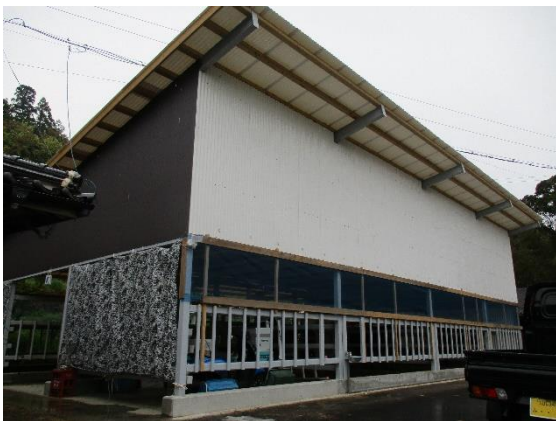
県事業を活用した畜舎の増築
