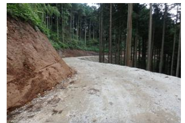
森林作業道の開設
