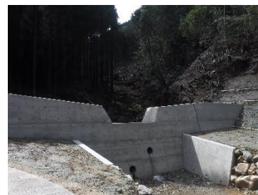
治山ダムの整備
