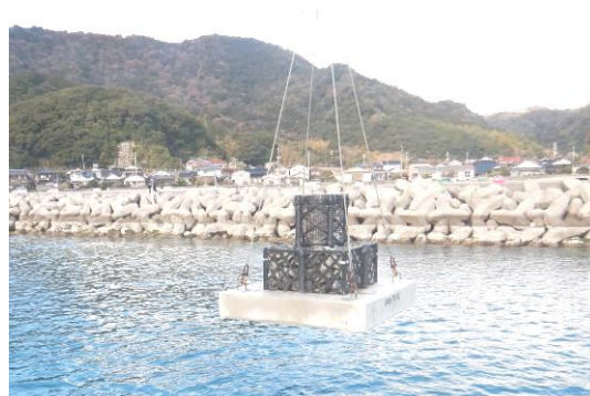
魚礁据付状況
