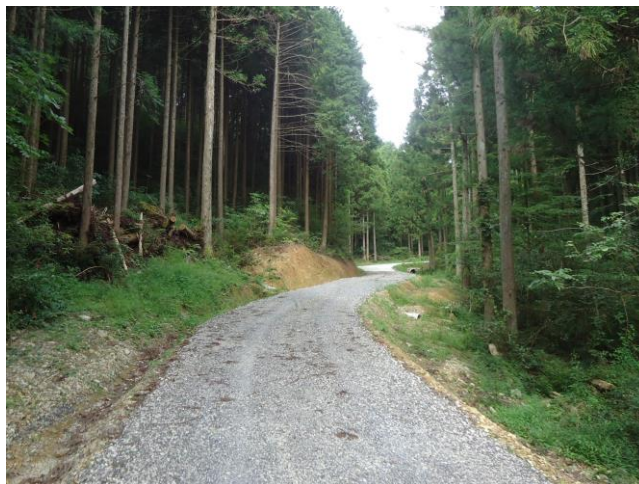
森林作業道の開設
