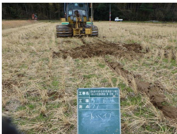
暗渠排水の施工状況 （黄波戸口地区）
