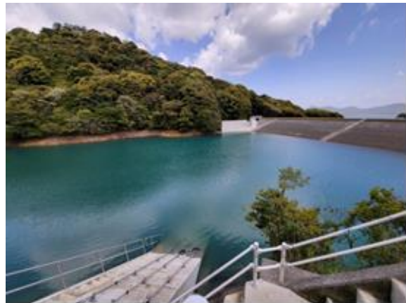
ため池の改修 （崩ノ河内第1地区）
