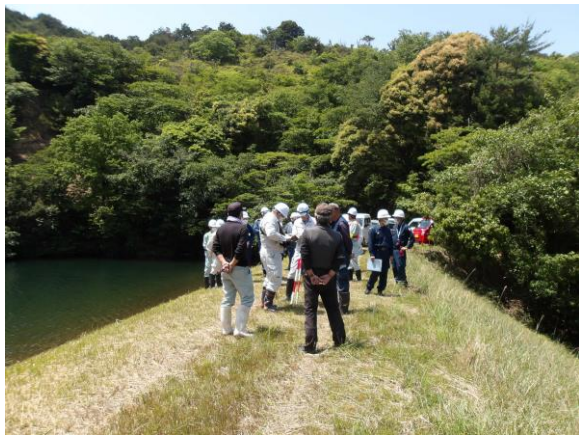
ため池点検パトロール （浴山第1ため池）
