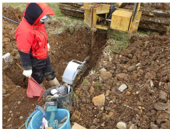
暗渠排水の施工状況 （黄波戸口地区）
