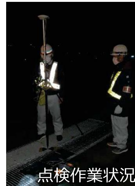
点検作業状況
