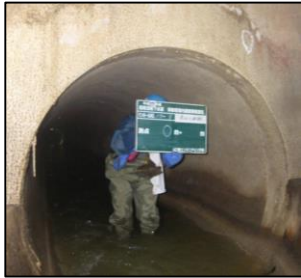
下水道函渠点検
