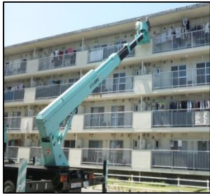
県営住宅外壁点検
