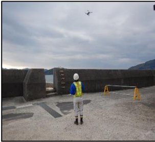
海岸護岸点検
