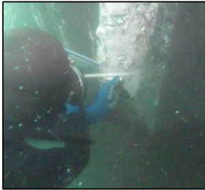
港湾岸壁点検
