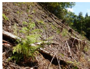
再造林施工状況
