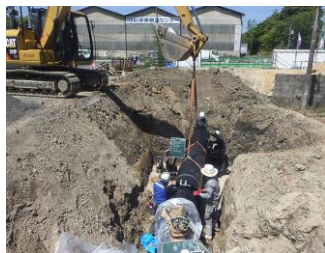
厚東川第2期水路ルートバイパス管布設工事
