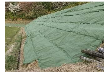
防草シートの設置
