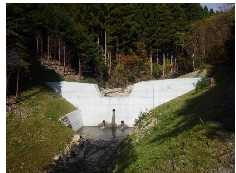
治山ダムの設置
