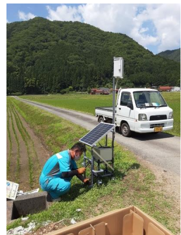
水田環境モニタリング装置
