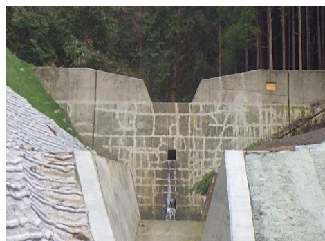
実施後（漏水・止水対策実施）
