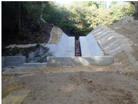
切開により用途廃止したため池
