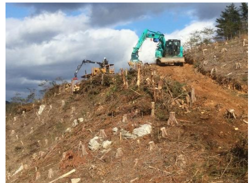
高性能林業機械による地拵え
