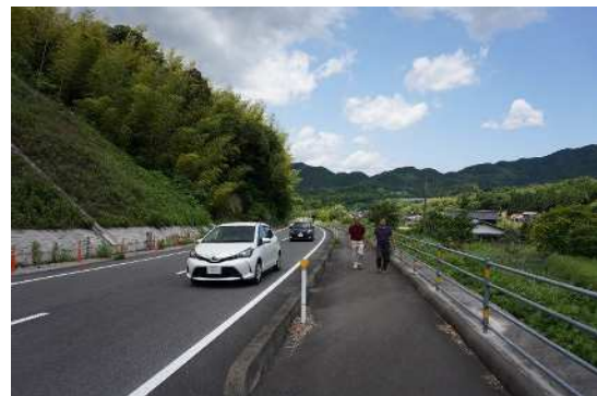
② 部分供用区間の状況
