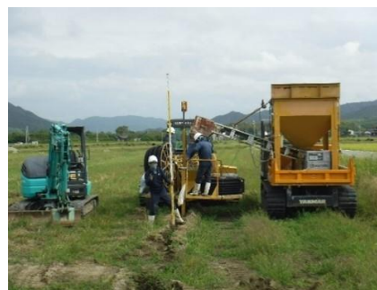
(水田高機能化 地下水制御システムの施工)
