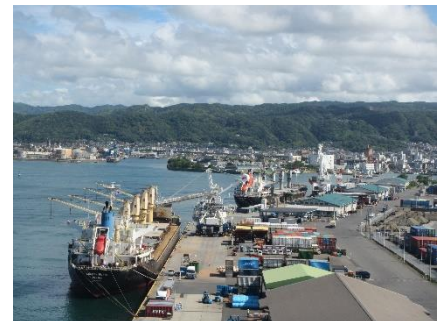
(港湾施設の整備 (耐震強化岸壁))
