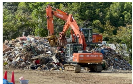
(集積された災害廃棄物の分別作業)
