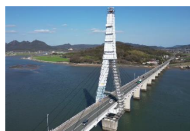
(老朽化対策 周防大橋 橋梁補修)
