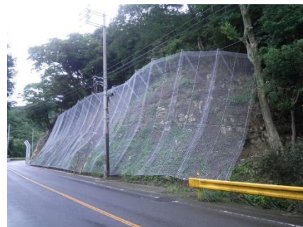
(県道萩篠生線 斜面の防災対策)
