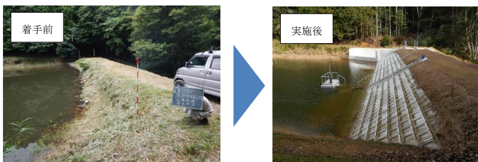
防災重点農業用ため池の改修整備
