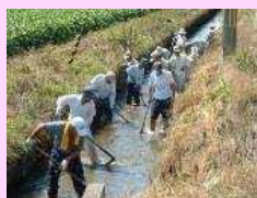
水路の泥上げ
