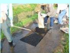
農道の部分補修
