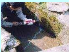
水路のひび割れ補修
