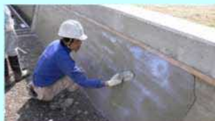
老朽化した水路壁のコーティング
