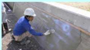
老朽化した水路壁のコーティング
