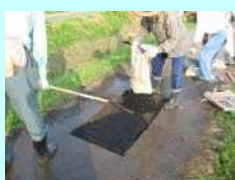
農道の部分補修
