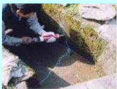
水路のひび割れ補修
