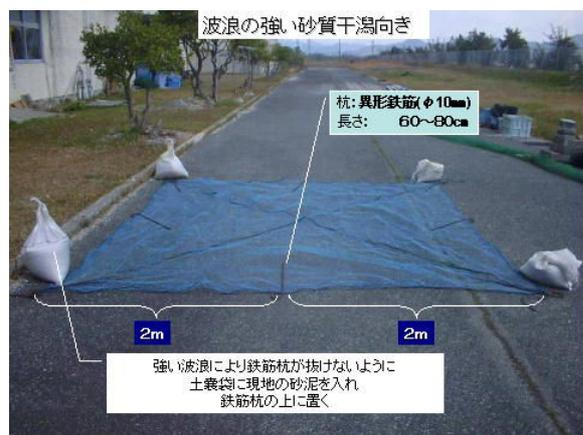
図5 鉄筋杭と土嚢による網の設置
