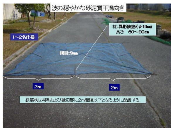
図4 鉄筋杭のみによる網の設置
