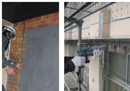
外壁改修工事
