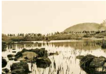
台風による嘉川付近の被害状況 (山口県文書館所蔵)
