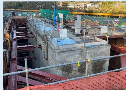
吸水井の耐震対策状況 [小瀬川工業用水道]
