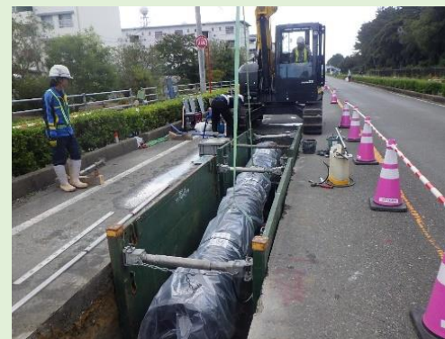
管路布設工&lt;&lt;(佐波川工業用水道)&gt;&gt;
