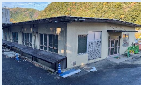
≪ポンプ棟の現況(小瀬川工業用水道)≫
