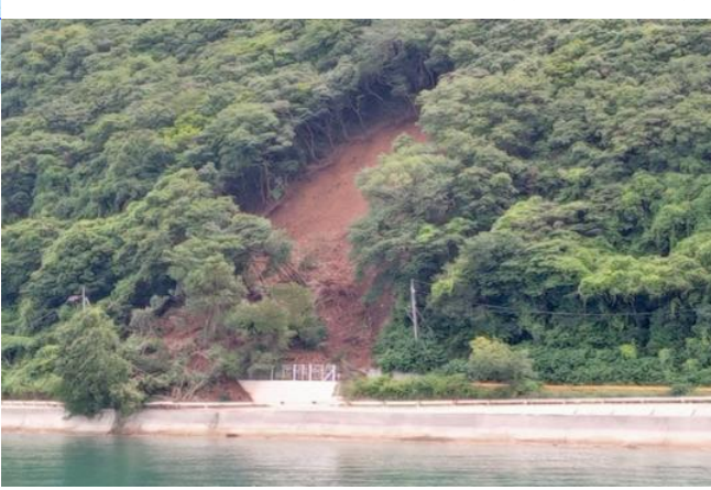
県道東浦西浦線【道路災】（柳井土建）
