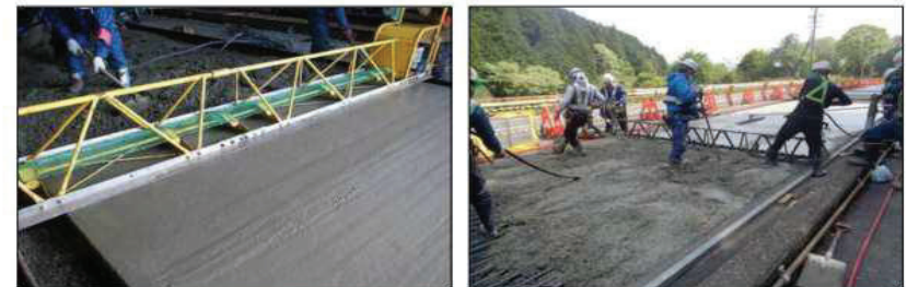
写真-3.8.8 荒仕上げ状況
