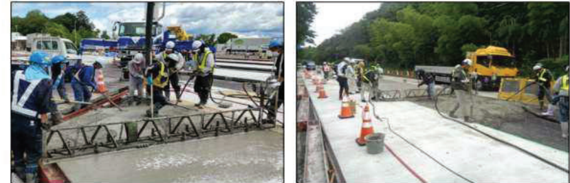
写真-3.8.7 締固め状況
