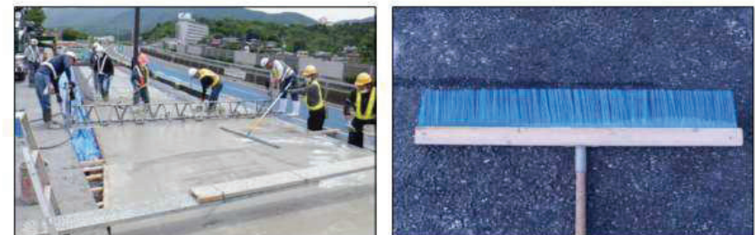
写真-3.8.9 フロートによる平坦仕上げと粗面仕上げ用ホウキの例
