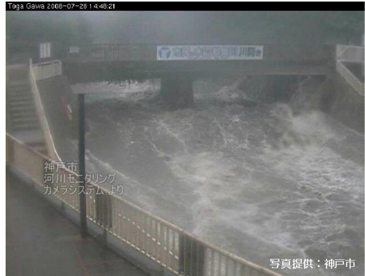
増水時の都賀川 (写真提供：神戸市)
