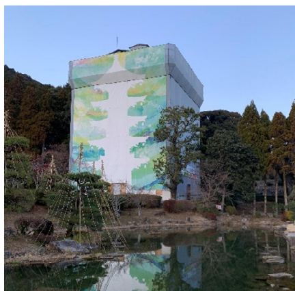
<改修中の様子>
