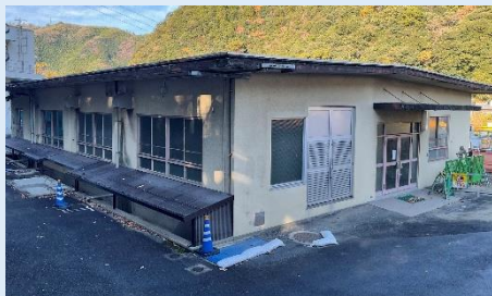
≪ポンプ棟の現況(小瀬川工業用水道)≫
