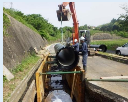
2期ルートバイパス管布設状況 [厚東川工業用水道]
