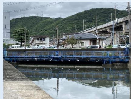
御影水管橋の現況 [周南工業用水道]
