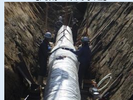
新管布設 [厚東川第2期工業用水道]
