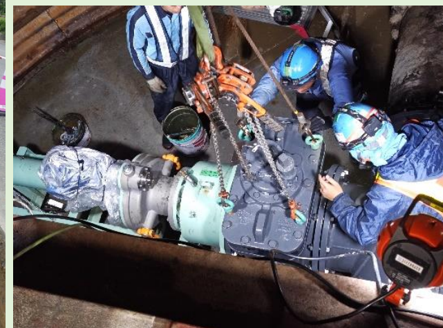
《開削工施工中の状況》
