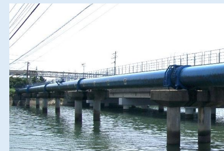
水管橋の耐震対策状況 [周南工業用水道]
