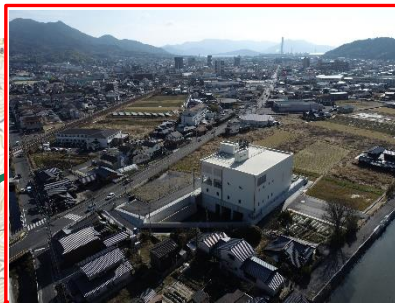
東土穂石雨水ポンプ場 完成写真
