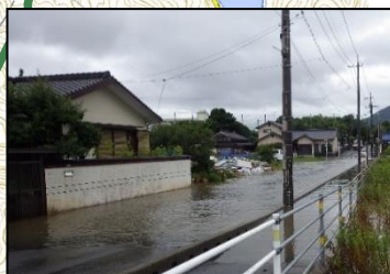
平成30年7月豪雨 浸水状況
