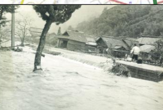
昭和29年9月洞爺丸台風 浸水状況
