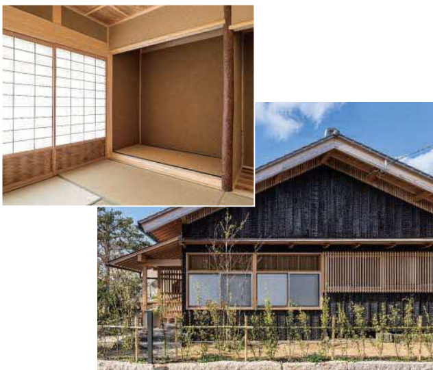
写真2-4 片面真壁造の土塗壁
