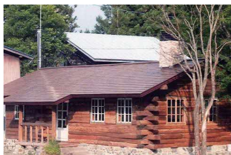
写真 3-5 丸太組構法 外部両面丸太現し（外部）
