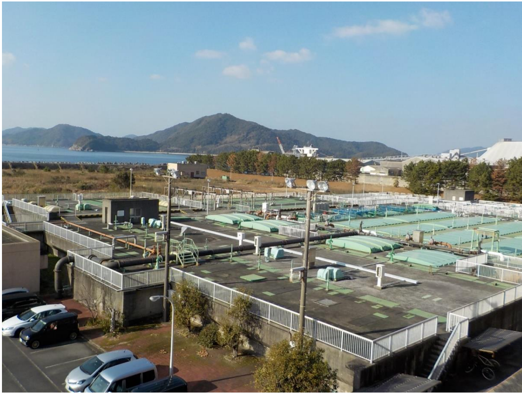
周南浄化センター全景
